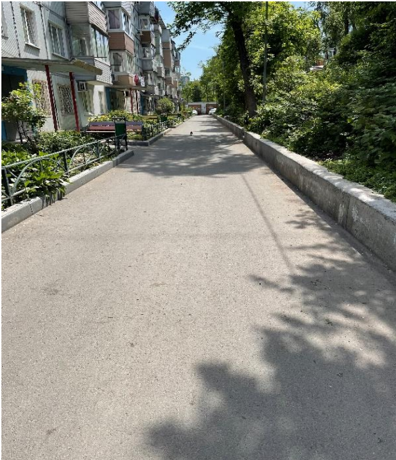
Проезд ул. Котельникова, 6-10.
